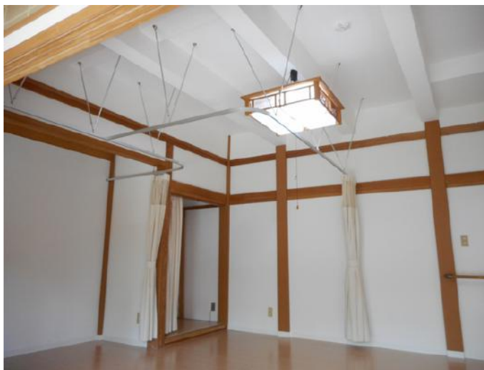
■ 天井内の梁や壁も強化石膏ボード仕上げ。 本物件は、空間の圧迫感を軽減するため 天井は張らずに、強化石膏ボードに不燃 クロス仕上げにしている
