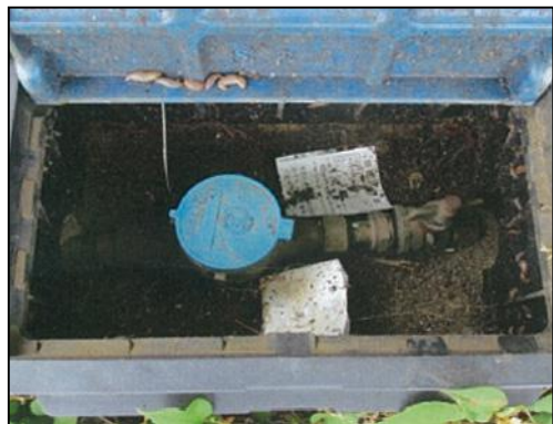
既存水道メーター：口径20mm
