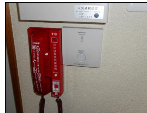
自火報と火災通報装置の 連動スイッチ
