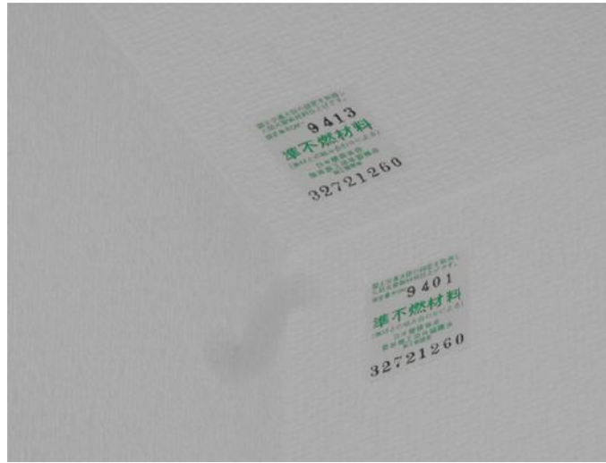
■ 居室の柱も強化石膏ボードに準不燃クロス仕上げ。 ■ 準不燃クロス
