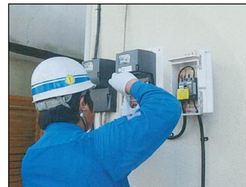
■ 1次側電源工事（東電委託工事） ↑ 専用ブレーカー設置
