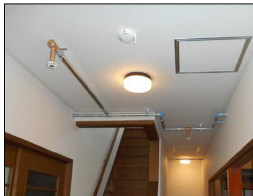
水道管 露出施工例（１） ・廊下
