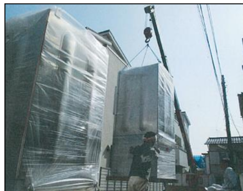
■ ユニック車でポンプユニット本体の搬入・設置
