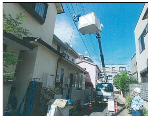
■ 1次側電源工事（東電委託工事） ↑ 専用ブレーカー設置
