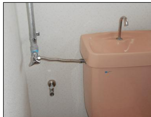
端末処理：停滞水防止のため、 トイレや洗濯機に接続
