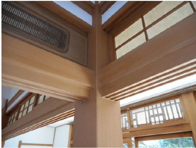
■ 居室の柱も強化石膏ボードに準不燃クロス仕上げ。 ■ 準不燃クロス
