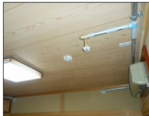
水道管 露出施工例（２） ・機能訓練室
