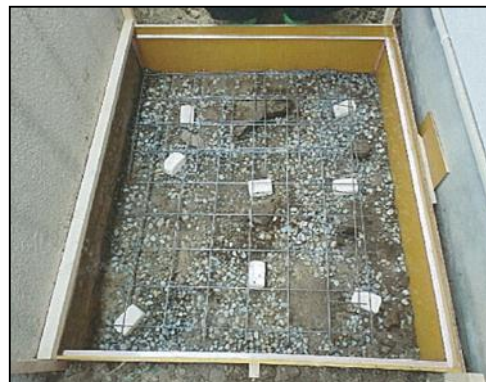
■ ポンプユニット設置の土台工事
