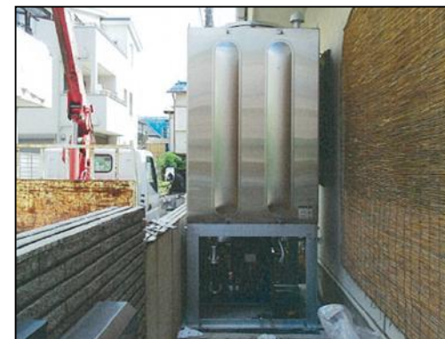
■ ユニック車でポンプユニット本体の搬入・設置
