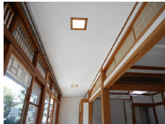
■ 木天井から強化石膏ボードに不燃クロス 仕上げ。
