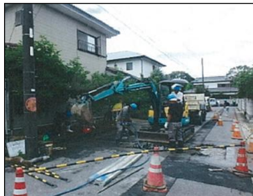
水道メーター増径工事（掘削）
