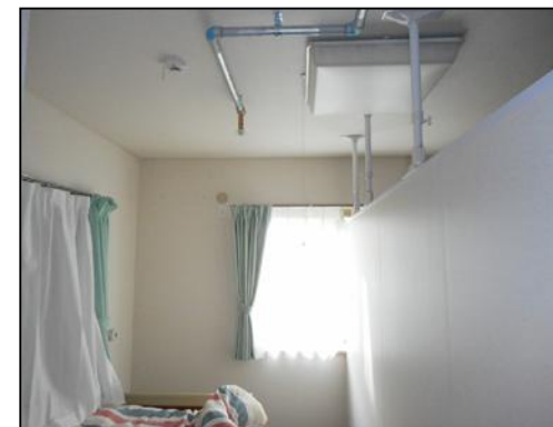
水道管 露出施工例（３） ・静養室
