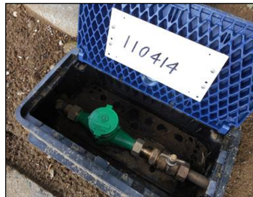
水道メーター増径完了：25mm
