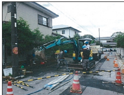
水道メーター増径工事（掘削）
