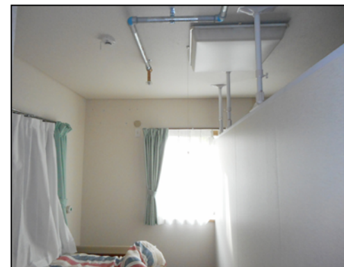
水道管 露出施工例（3） ・静養室
