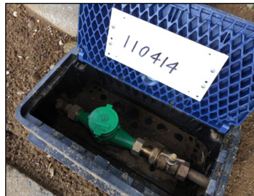
水道メーター増径完了：25mm
