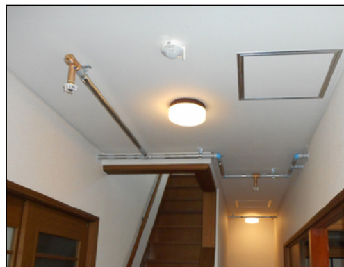
水道管 露出施工例（1） ・廊下
