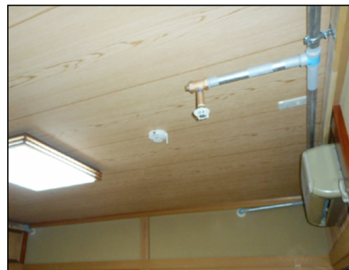
水道管 露出施工例（2） ・機能訓練室
