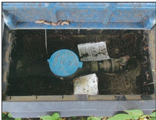
既存水道メーター：口径20mm
